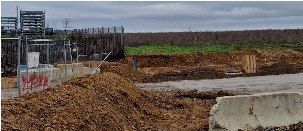
Figure 2. Vue du terrain depuis la route de la ZAC visite le 27-01-2023
